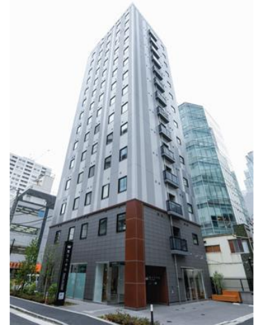
変なホテル東京 浜松町 外観
